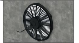
**Ventilator:** Für die Ableitung überschüssiger Wärme, die nach dem Ausschalten des Motorgenerators entstehen kann, gibt es in dem Container ein Ventilator, der durch einen Thermostat einstellbar ist.
