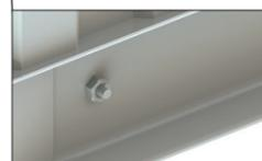
**Erdungspunkte:** Auf dem Containerrahmen gibt es seriell Zinkerdungspunkte für den sicheren Potentialausgleich.
